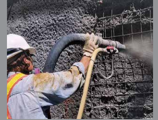
Concreto lanzado
