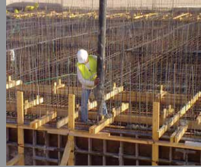
Concreto vertido en sitio
